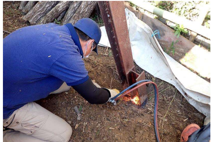
◇ 炭焼き場小屋裏の鉄骨処理 ホダ木置き場安全です、広くなりました
