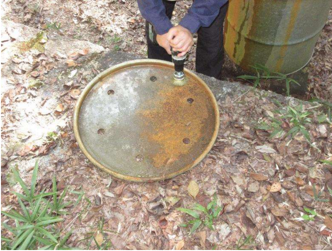
◇ 南砂防広場 防火水槽蓋錆び取り
