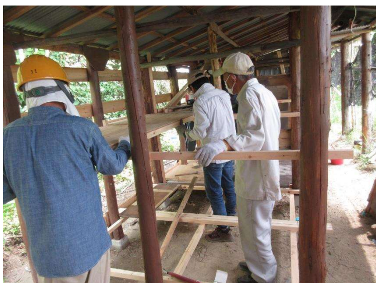
◇ 炭焼き小屋の柱交換整備
