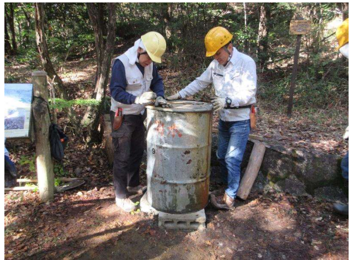
◇ 南砂防広場防火水槽の基礎取り換え
