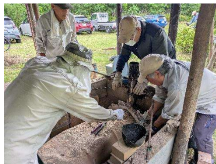
★6/26 炭焼き窯の解体
